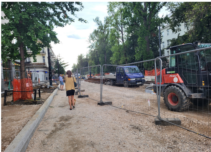
Przejście dla pieszych podczas remontu w Warszawie, 2025. Fot: zbiory własne Clean Cities Campaign.
