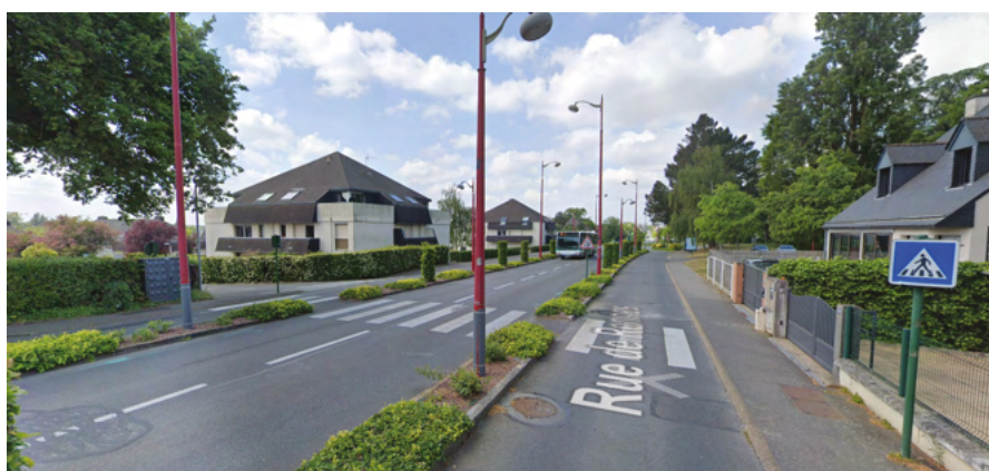
Ilustracja 7. Ulica lokalna z centralną jezdnią autobusową i ruchem samochodów po jezdniach bocznych. Pasy zieleni oddzielające jezdnię autobusową pozwalają uniknąć sygnalizacji na przejściach dla pieszych. Rennes, Francja. Źródło: Google Maps
